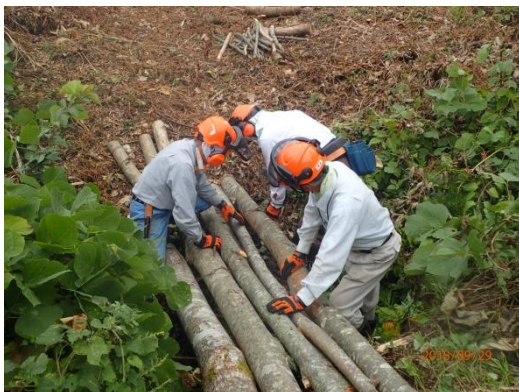
番線で橋の補強作業
