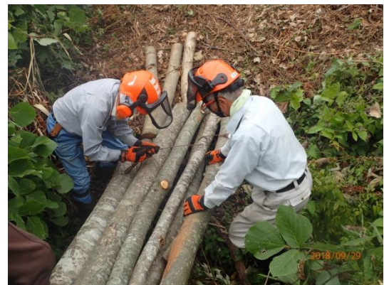
番線で橋の補強作業
