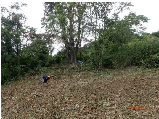
整地された植樹場
